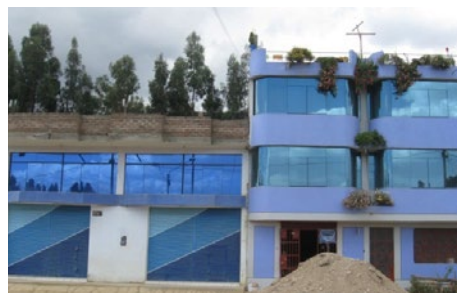
FOTO 6: VIVIENDA DE MATERIAL NOBLE
