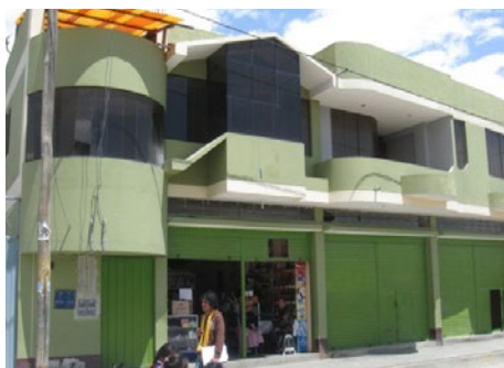
FOTO 5: VIVIENDA DE MATERIAL NOBLE
