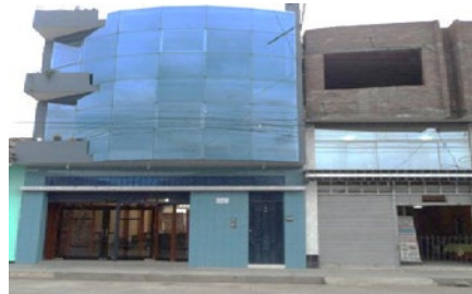
FOTO 11: VIVIENDA DE MATERIAL NOBLE
