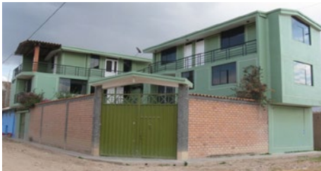
FOTO 9: VIVIENDA DE MATERIAL NOBLE
