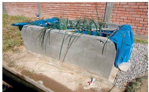
Figura 3. Humedal construido de flujo superficial
